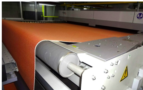
图为烘箱出口处的冷却区域
